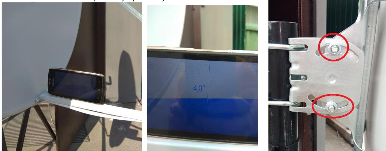
Для правильного выставления угла места необходимо предварительно ослабить 2 гайки фиксации положения антенны по углу места, выставить антенну на необходимый угол и после этого затянуть гайки.
