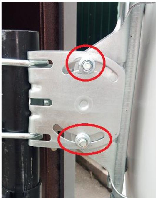
1. Ослабьте две гайки хомута фиксации антенны по углу места и смещением в вертикальной плоскости добейтесь максимального уровня сигнала, используя любое из устройств наведения.
