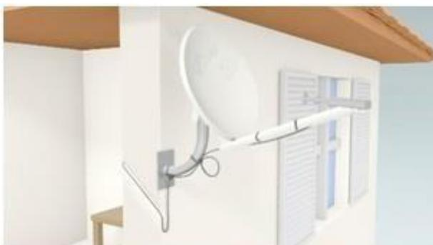
Сверление отверстия для ввода кабелей производите под наклоном, для предотвращения попадания влаги внутрь помещения. При вводе кабелей в помещение не забудьте оставить «конденсатную» петлю.
