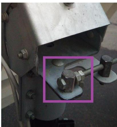
Начните точное наведение в горизонтальной плоскости, смещая зеркало антенны на ОПУ болтом точной подстройки по азимуту в любом направлении. Сверяясь с показаниями в web-интерфейсе, добейтесь максимума. Затяните стопорные гайки.
