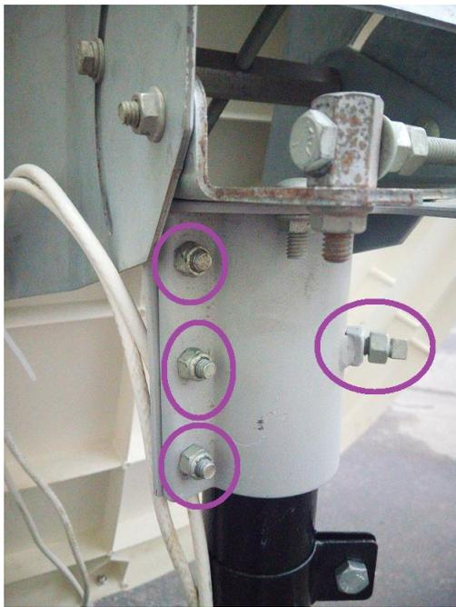
Разместите собранную антенну на предварительно установленном кронштейне. Несильно затяните гайки, фиксирующие ОПУ антенны на кронштейне, чтобы обеспечить возможность вращения антенны целиком в горизонтальной плоскости.
